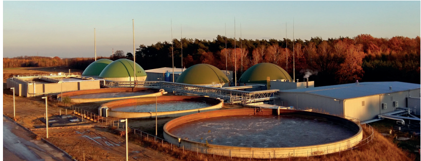
Fig. 3: Complete afvalwaterzuivering en biogasinstallatie in Polen
